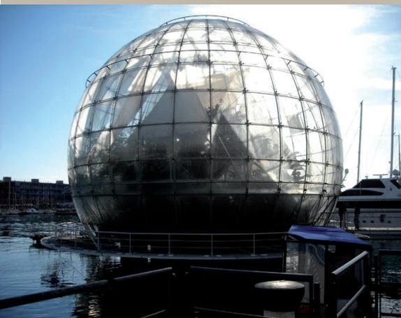
Découverte également de **la Bolla**, structure sphérique de 20 mètres de diamètre suspendue au-dessus de la mer. Faite d'acier et de verre, la sphère réinvente un espace unique où la faune et la flore tropicales jouissent d'un micro climat crée artificiellement.
